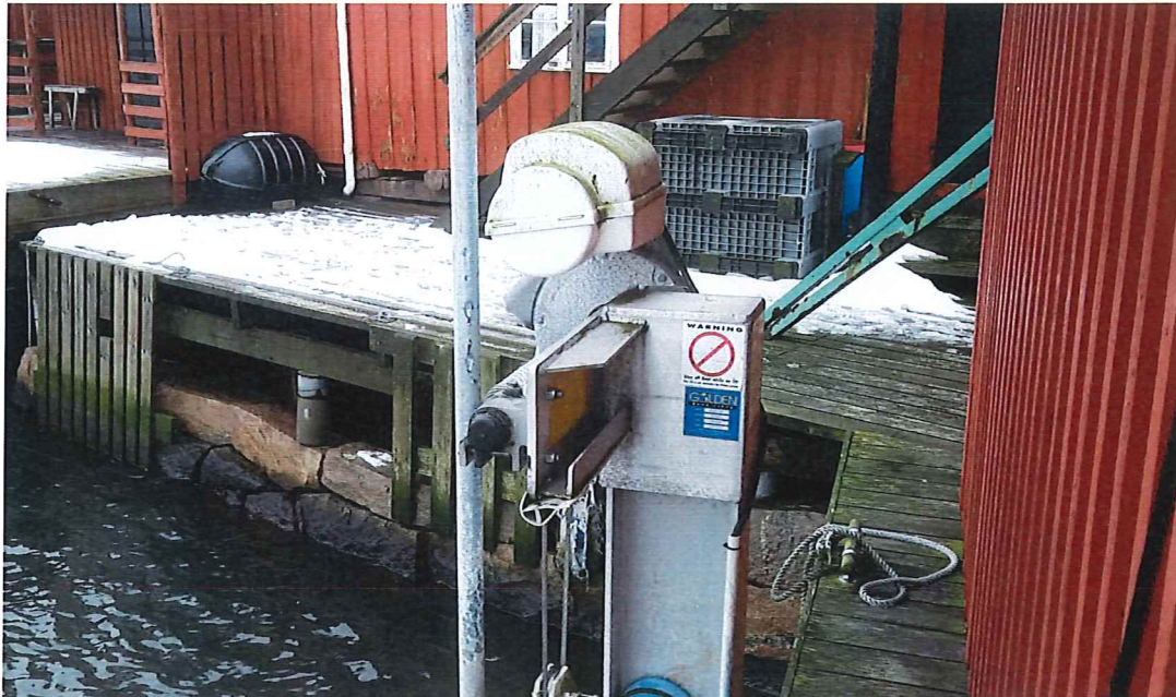
Figur 6. Stenmur framför byggnad.
