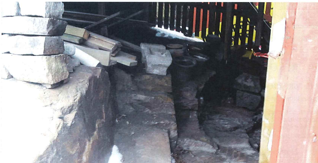
Figur 5. Foto på bergklack alldeles norr om aktuell byggnad.
