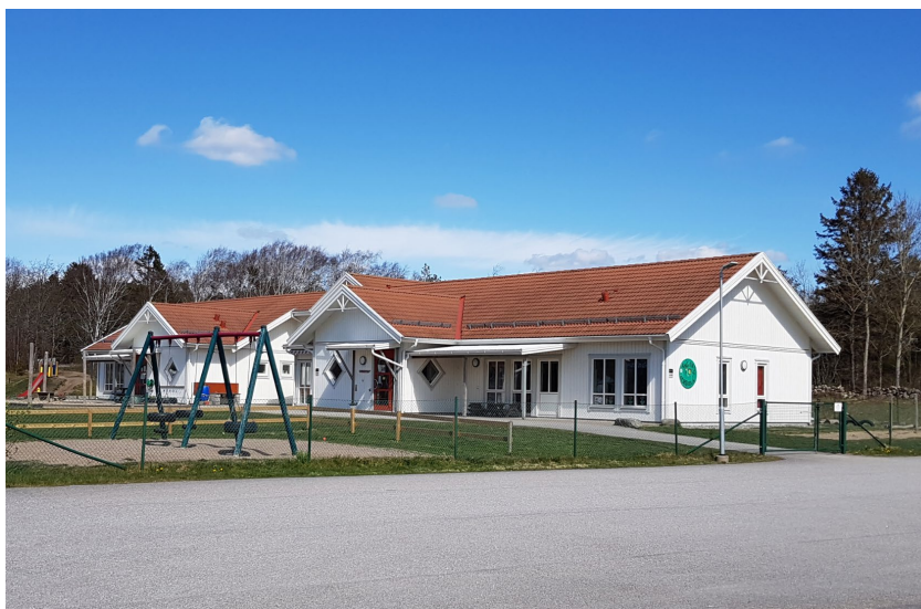
Bild på befintlig byggnad för Ängens förskola.
