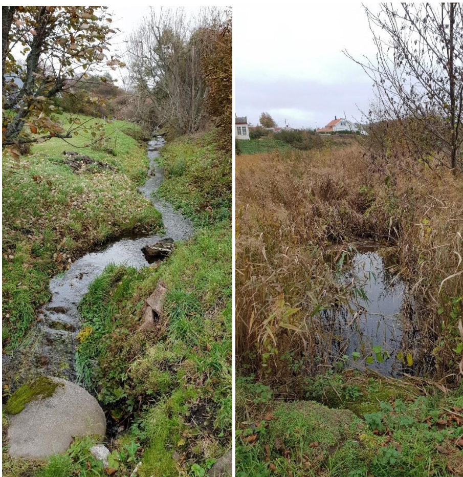
Figur 6 Bilder tagna vid platsbesök (2018-10-09) från gångvägen mot bäcken uppströms (vänster) och nedströms (höger). Trumman under gångvägen är en betong 600 mm.
