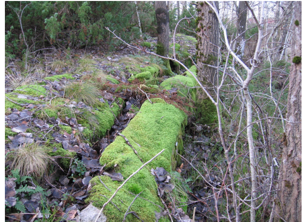
Bild 3-4. Uppsprickning i den västra hällens norra del. Bergryggens höjd är maximalt 1 m.
