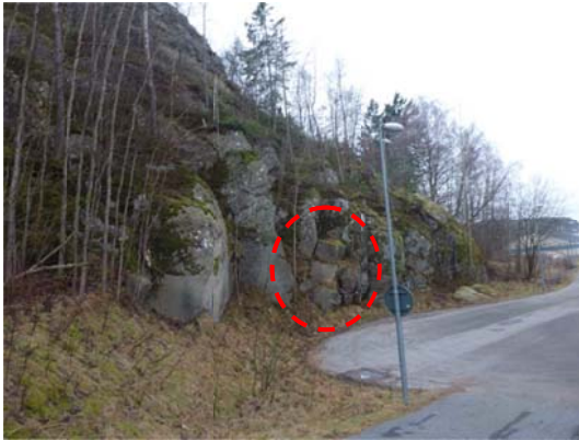
Foto 10. Block som bedöms kunna falla ut ner på vändzonen. Foto 11. Närbild av blocken
