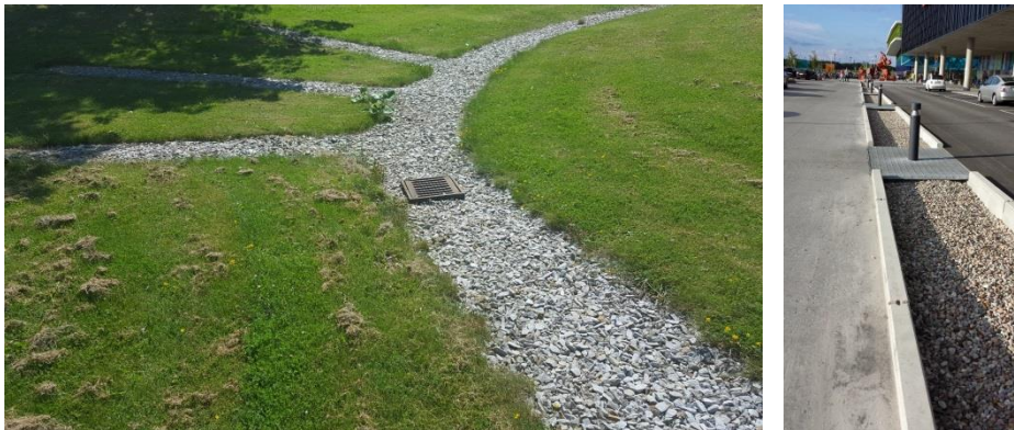
Figur 9. Makadamdike på gräsyta vid Kemicentrum på LTH i Lund (t.v.) och makadamdike på parkeringsplats (t.h).
