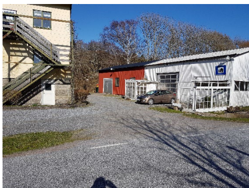
Förrådsbyggnad på Hee 1:60
