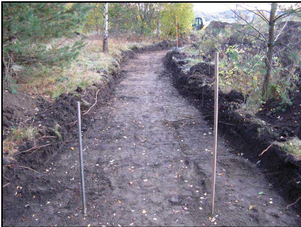
Figur 20. FU-schakt 2 med utredningsschakt. Foto AC2008-30-O-1020.
