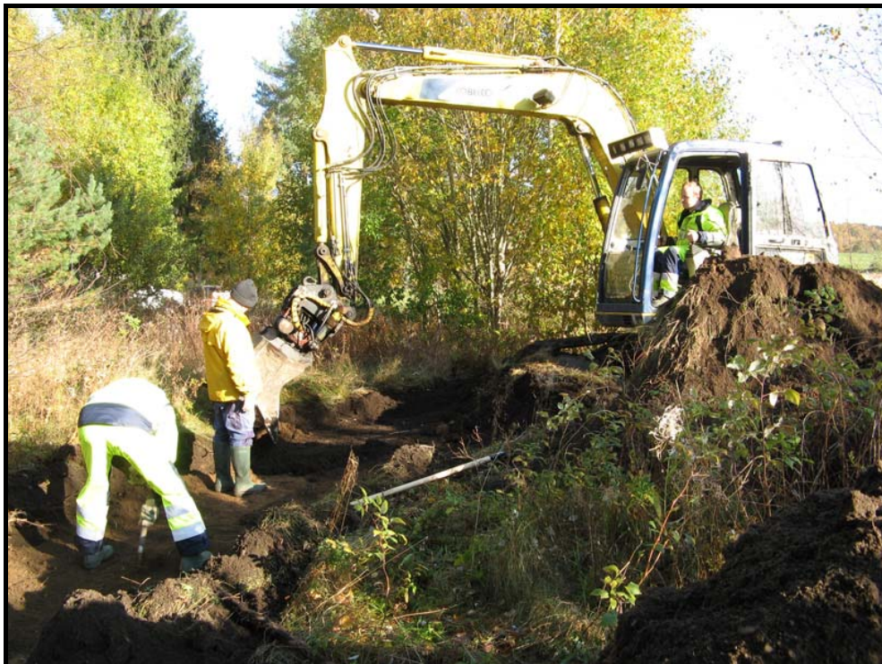
Figur 4. Arbetsbild. Sökschaktning inom FU4b. Foto Maria Hinnerson Berglund (privat).
