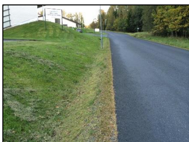
Figur 16: Bild på ett svackdike vid väg.
