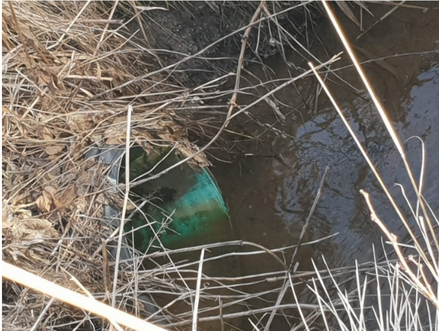
Figur 8. Trumma dimension cirka 400 mm vilken mynnar i norr delen av Ertserödsbäcken.
