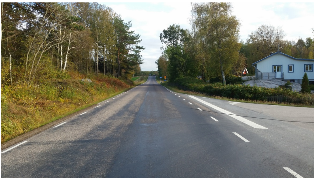
Bild 2. Väg 163 i sydlig riktning. Till höger ansluter Tanumstrandsvägen, vilken är reglerad med stopplikt.
