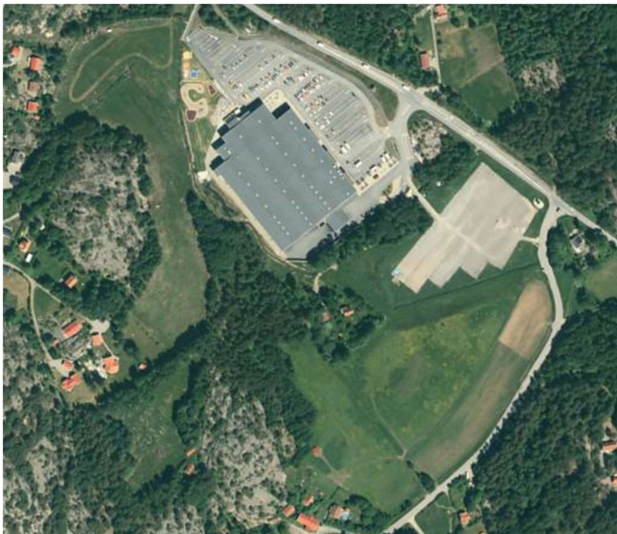
Sportshopen etapp 3, Ertseröd 1:53, Tanum Geoteknisk undersökning inför detaljplan Göteborg, 2020-07-03
