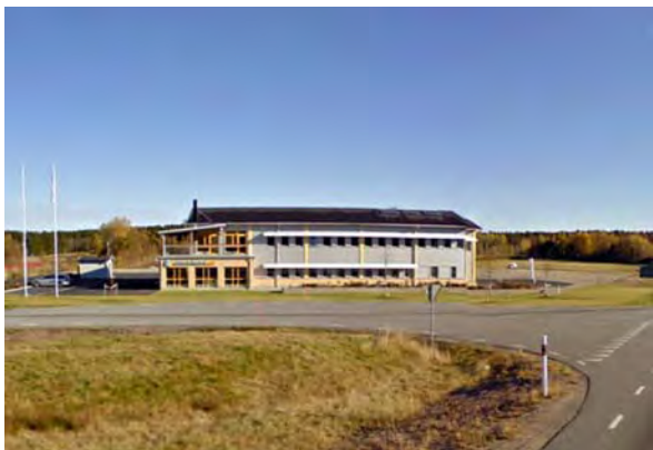
Bild 1. Området från väster. Huvudkontoret för Rabbalshede Kraft AB är byggt 2010.
