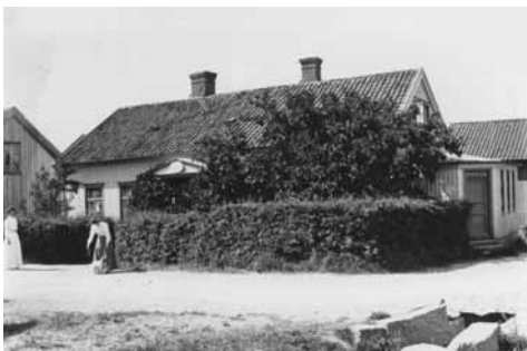
Sannäs 3:12 (hus nr 49). Här kan man se att gatan är belagd med grus. Källa: Ingemar Lantz
