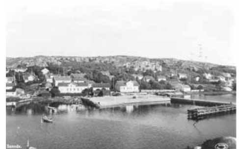
Sannäs brygga och hamn 1939. Till höger i bilden syns arbetet på Nya vägen som inte är klar än. Stenbryggan är klar samt träbryggan i vinkel. Källa: Ingemar Lantz
