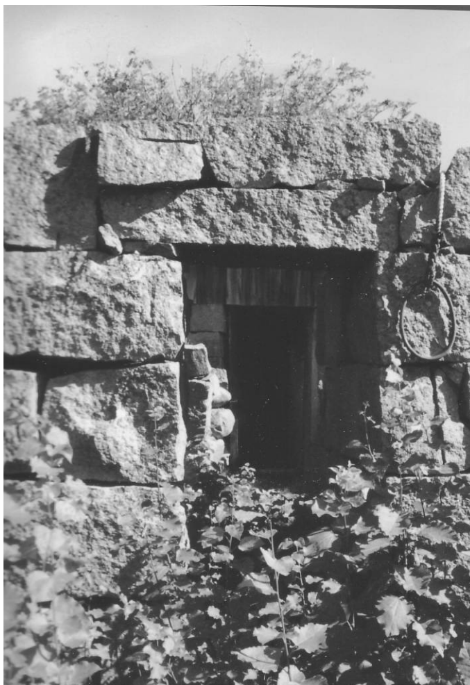
Resterna av kruthuset vid Backegärdet.
