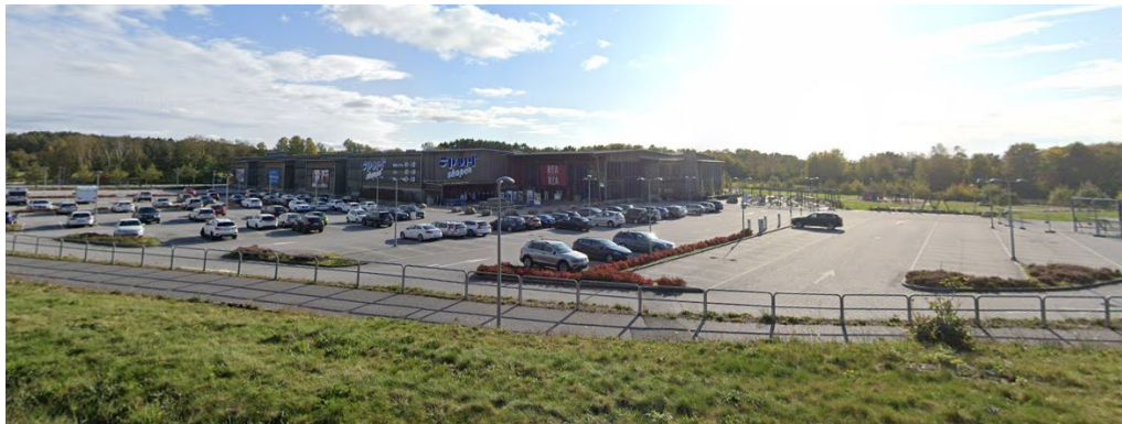
Befintlig handelsanläggning med vy från väg 163.
