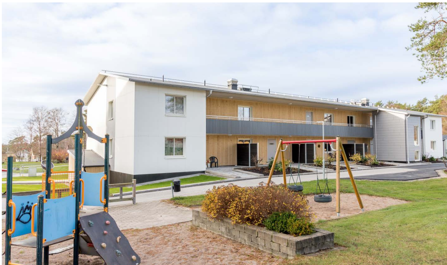
Samma hus men annan vägg efter renoveringen, modernt och fräscht.
