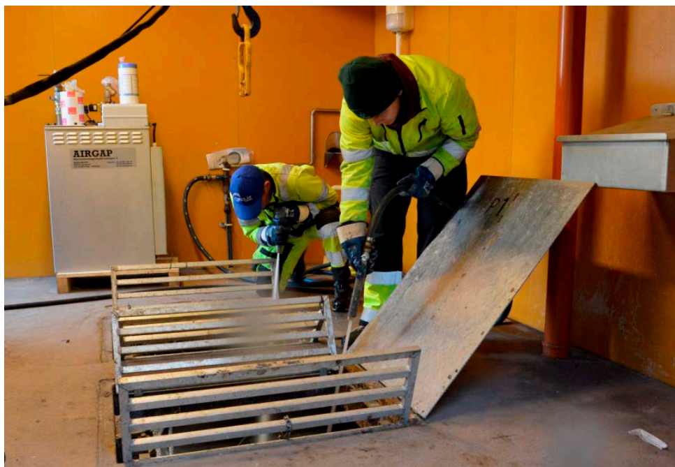
Stefan Claesson från Rambo och praktikanten Neo Carlquist (närmast kameran) avslutar slamsugningen i pumpstationen med att spola rent gropen med vatten.
