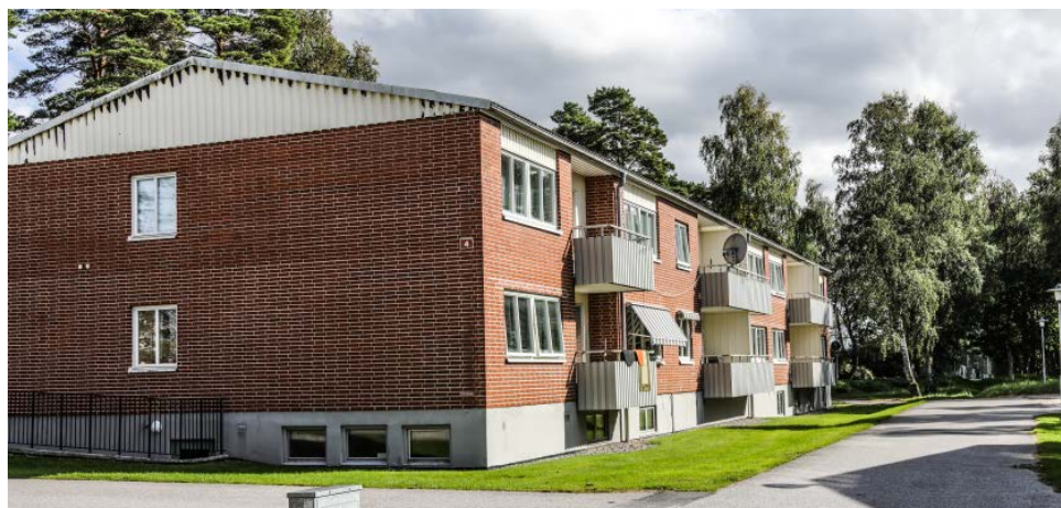
Furuvägens ena hus från 70-talet före renoveringen.
