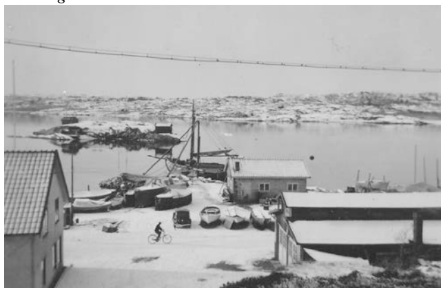
Söder om konservfabriken låg det i mitten av 1900-talet en båtupptagningsplats. Källa: Föreningen Gamla Grebbestad
