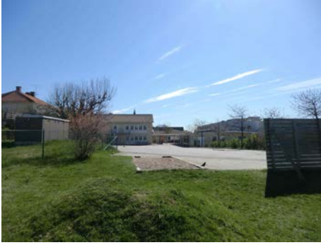
Huskropparna byggda på 1960- och 70-talen.
