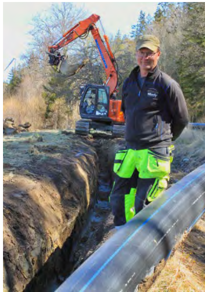
Lars Adlersson har tillsammans med kollegor anlagt drygt en kilometer ny råvattenledning vid Mungseröd, mellan Nedre Bolsjön och Tanumshede.
