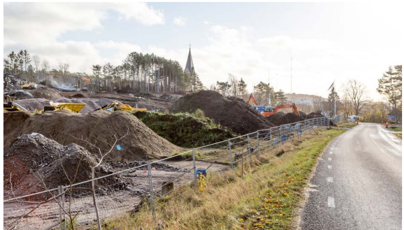
Full fart på markarbetena på området Anneberg i Grebbestad.
